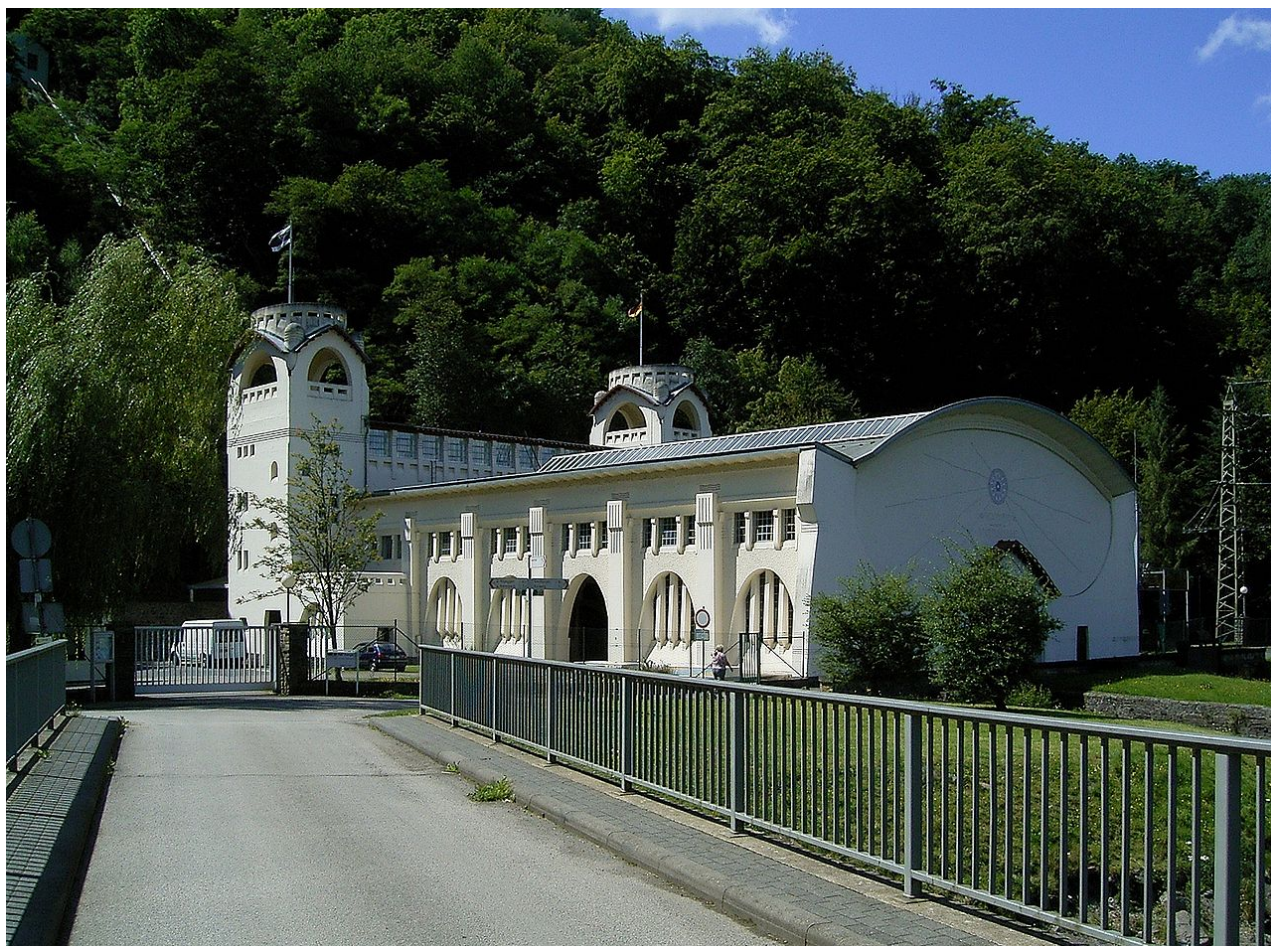
Wasserkraftwerk Heimbach (©Frank Vincentz - Wikipedia)
